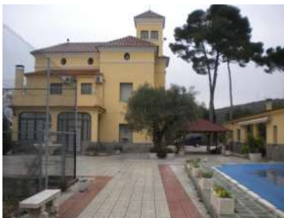
FIGURA Nº2: Instalaciones exteriores del CA. Can Miralpeix. Fuente: elaboración propia.
